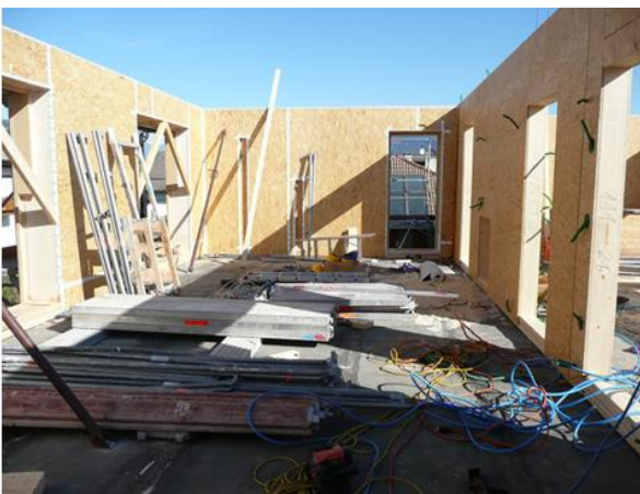
Edificio Plurifamiliare R., Caldaro sulla Strada
