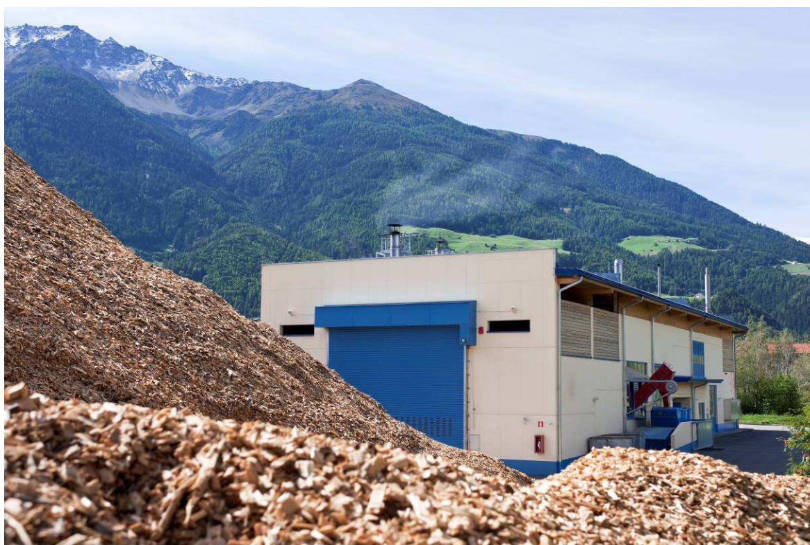
Fig. 2: Impianto di teleriscaldamento a biomassa del comune di Prato allo Stelvio
