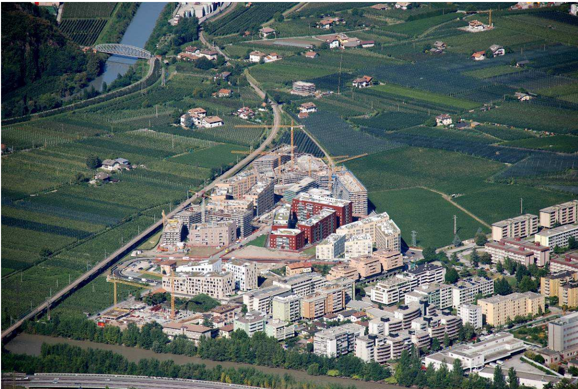
Fig. 1: Nuovo quartiere Casanova di Bolzano, in fase di costruzione.
