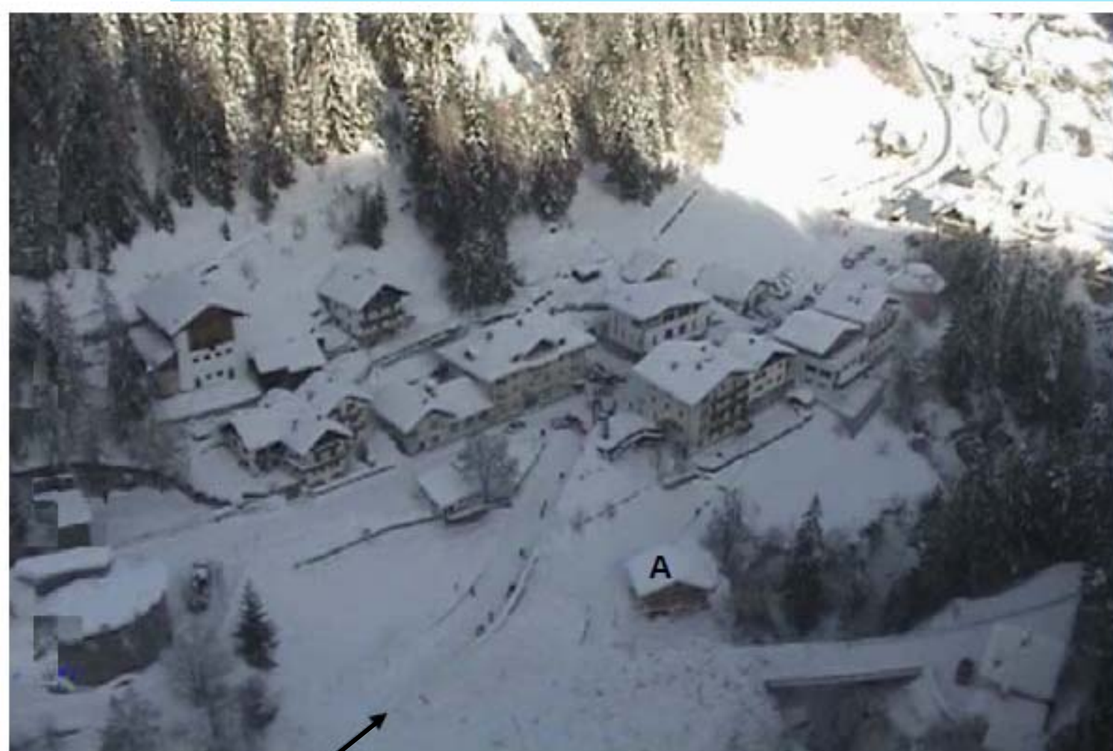
Gurgllawine 9.2.2009: Waldschaden, Strassenverschüttung, Lawinenschnee in Garage im Gebäude A neben der Brücke, sekundäre Lawine in den Gafaungraben
