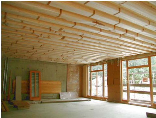
Abb. 2-5: Mit BSP-Platten aufgebaute Rippenplatte und herstellbarer Kastenquerschnitt
