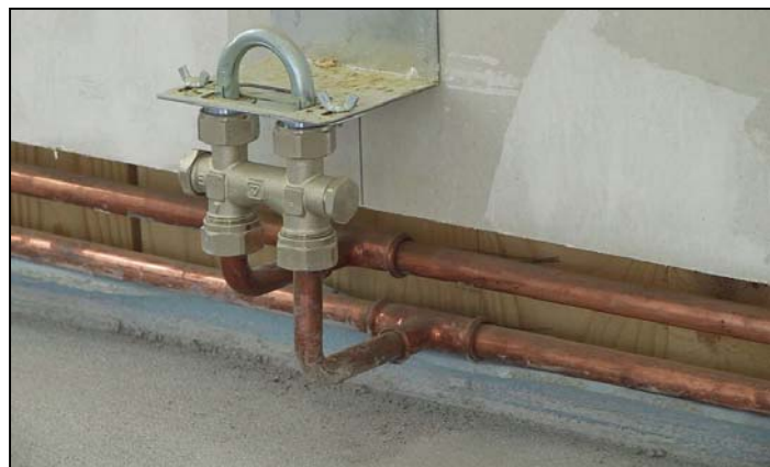
Abb. 4-11: Heizungsinstallation oberhalb der Fußbodenkonstruktion
