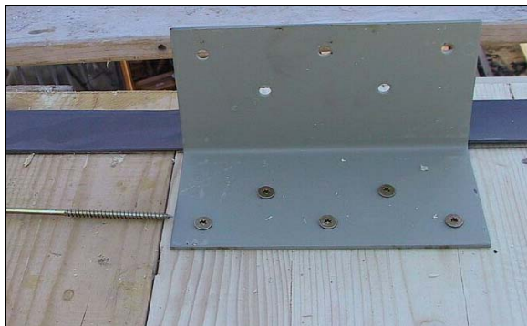
Abb. 4-7: Vorbereitete Befestigungswinkel und Dichtstreifen vor dem Einheben der Wandelemente
