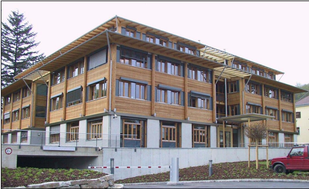
Abb. 4-13: Gesamtübersicht des neuen Bürogebäudes der ÖBF AG
