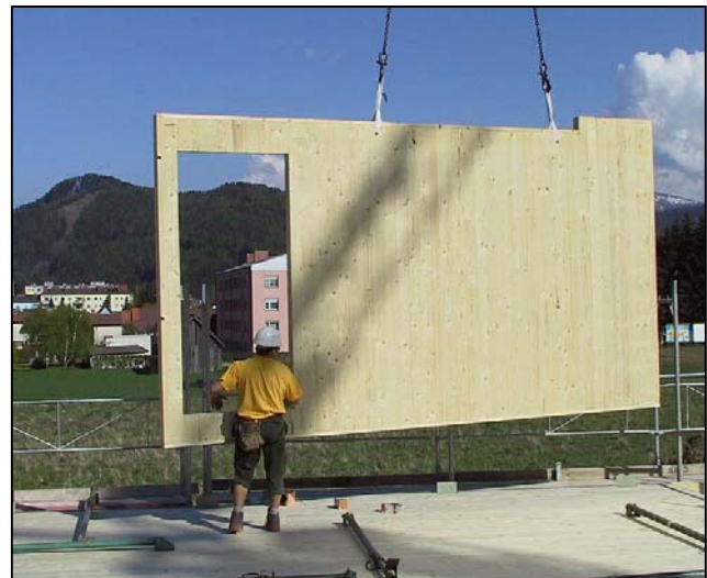
Abb. 4-8: Einheben eines Wandelementes
