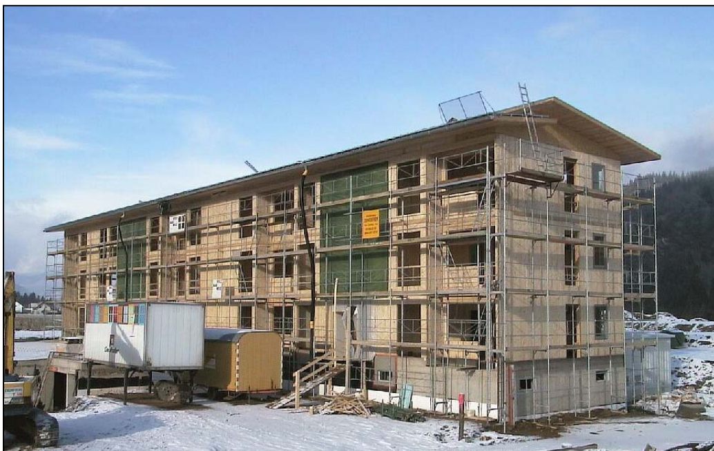
Abb. 4-1: Block A in der Rohbauphase
