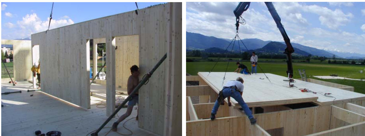
Abb. 2-2: Rohbau: Versetzen von Wänden, Einheben von Decken
