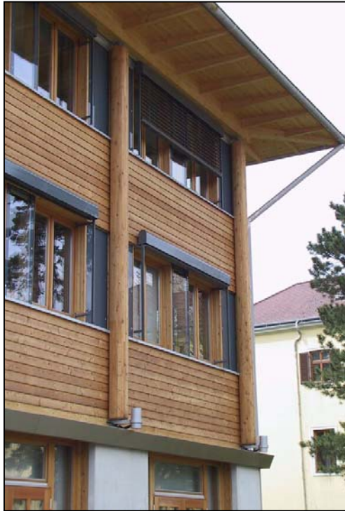
Abb. 4-17: Lärchenrundholzsäulen an der Fassade
