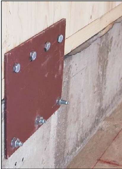
Abb. 4-5: Befestigung der Wandelemente im Sockelbereich im EG
